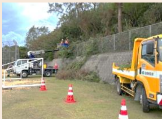
高所作業車での作業
